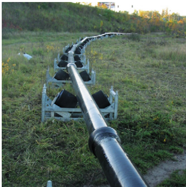
Fot. 1. Rurociąg po udanej próbie ciśnieniowej, przygotowany do zabudowy
