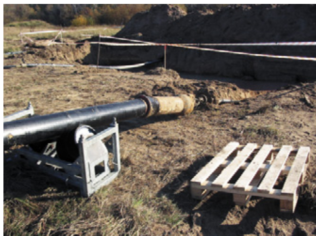
Fot. 2. Rurociąg z żeliwa sferoidalnego tuż przed wciągnięciem
