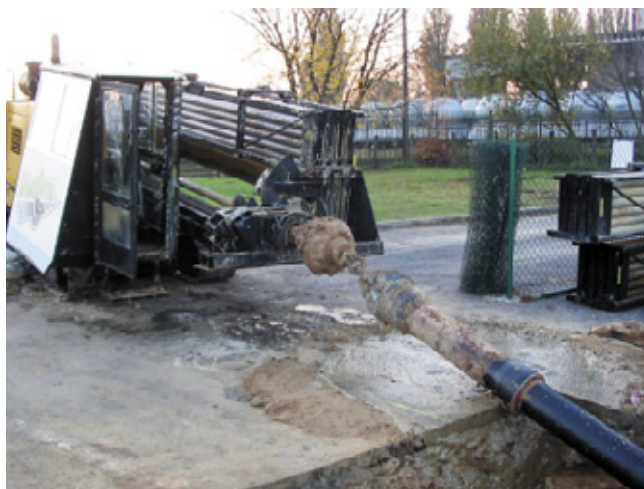
Fot. 3. Wiertnica Vermeer D50x100a w chwilę po zabudowie rury
